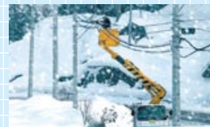
▲雪の中の作業
